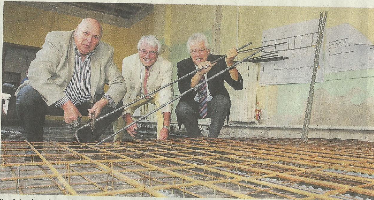
Der Beton kann kommen: Hansgeorg Hauser , Klaus D. Müller und Wilhelm Havermann (v.l.) im Haus der Seidenkultur. Der Boden ist für den Guss einer Betonplatte vorbereitet.
